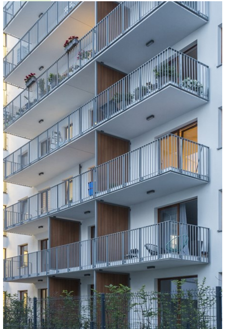
Dom Awangarda, Warszawa
