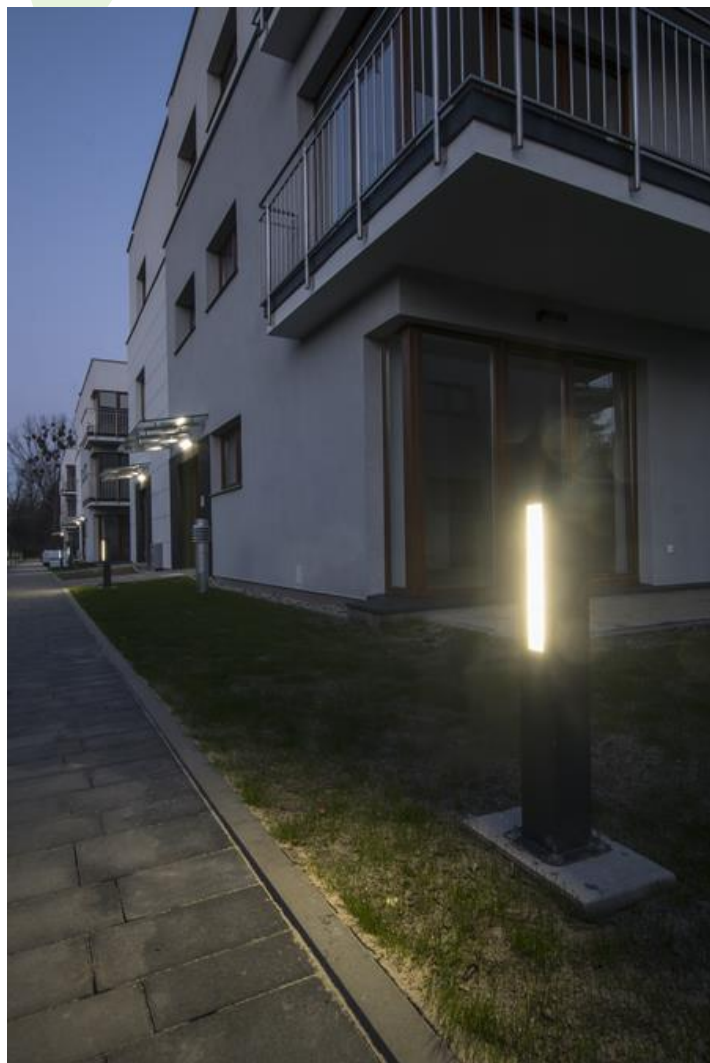
Mieszkania ul. Sklepowa 22, Warszawa
