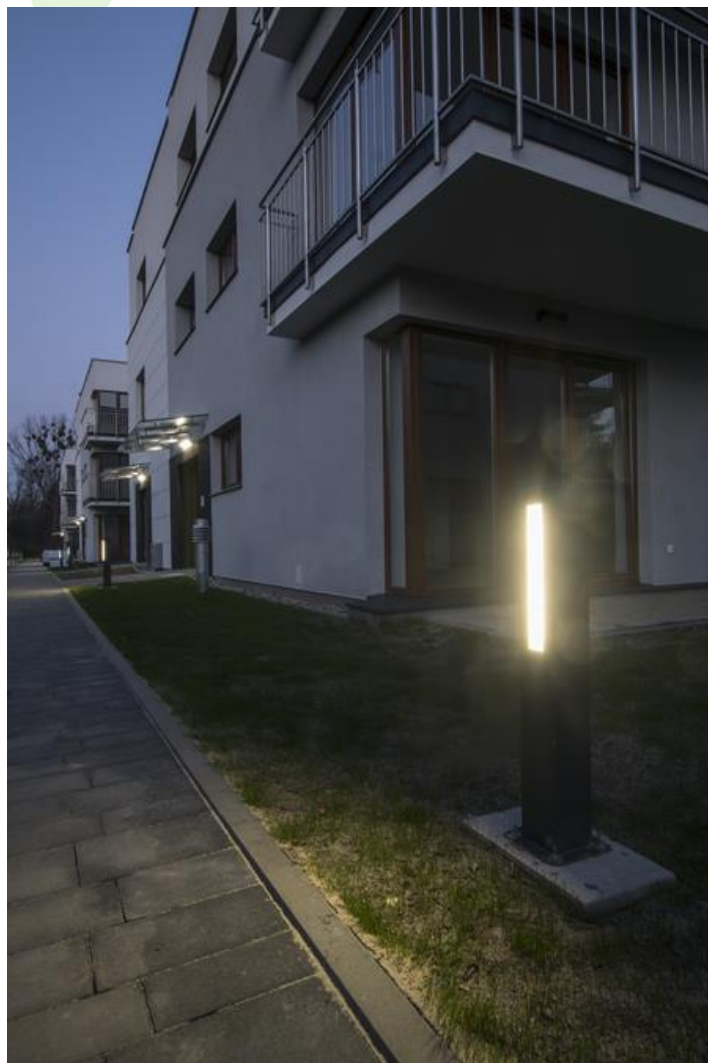
Mieszkania ul. Sklepowa 22, Warszawa
